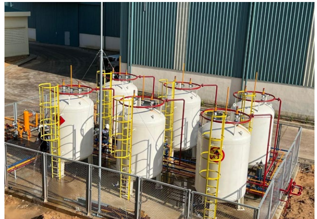
NÂNG CẤP, CẢI TẠO HỆ THỐNG GAS Gas system upgrading and renovation
