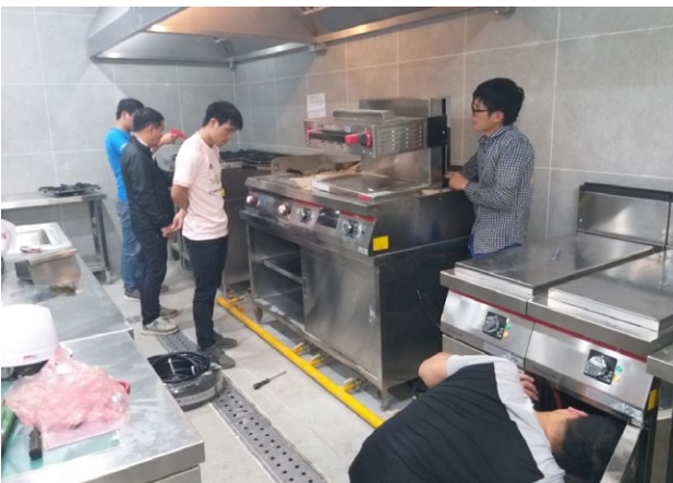
SỬA CHỮA HỆ THỐNG GAS Gas system repair
