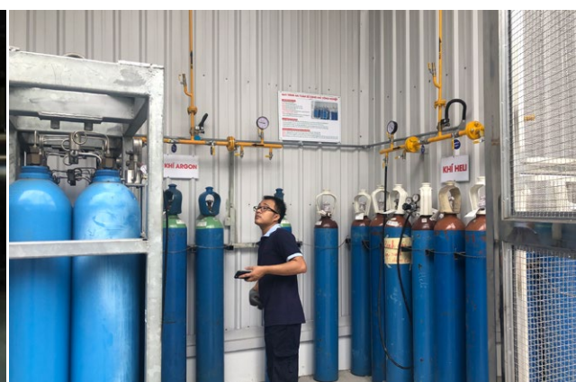
Lắp đặt hệ thống cung cấp khí công nghiệp Installation of industrial gas supply system
