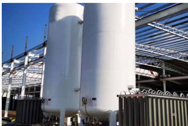
Lắp đặt trạm cung cấp khí công nghiệp Installation of industrial gas supply system
