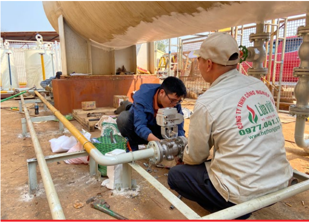
BẢO DƯỠNG HỆ THỐNG GAS Gas system maintenance
