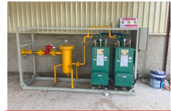
Bộ KIT hoá hơi gas Gassification KIT set
